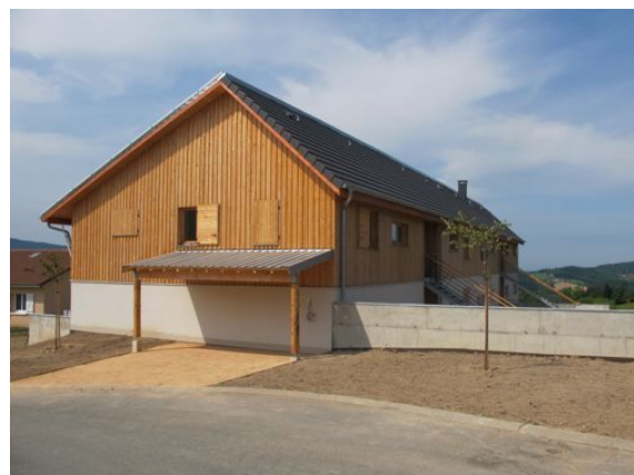
Pan Sud avec les panneaux photovoltaïques
