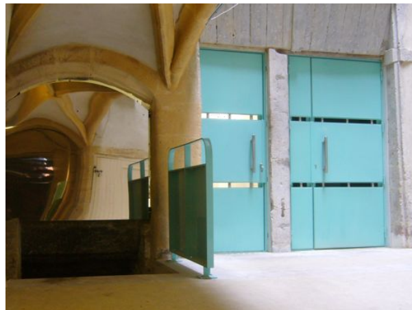
Nouvelle porte dans la cour
