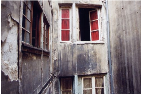
Etat de la façade avant les travaux
