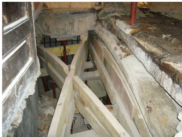
Restauration de la voûte
